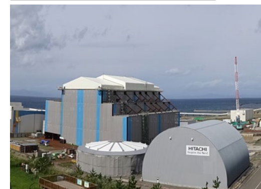
建設状況（2023年9月末時点）
