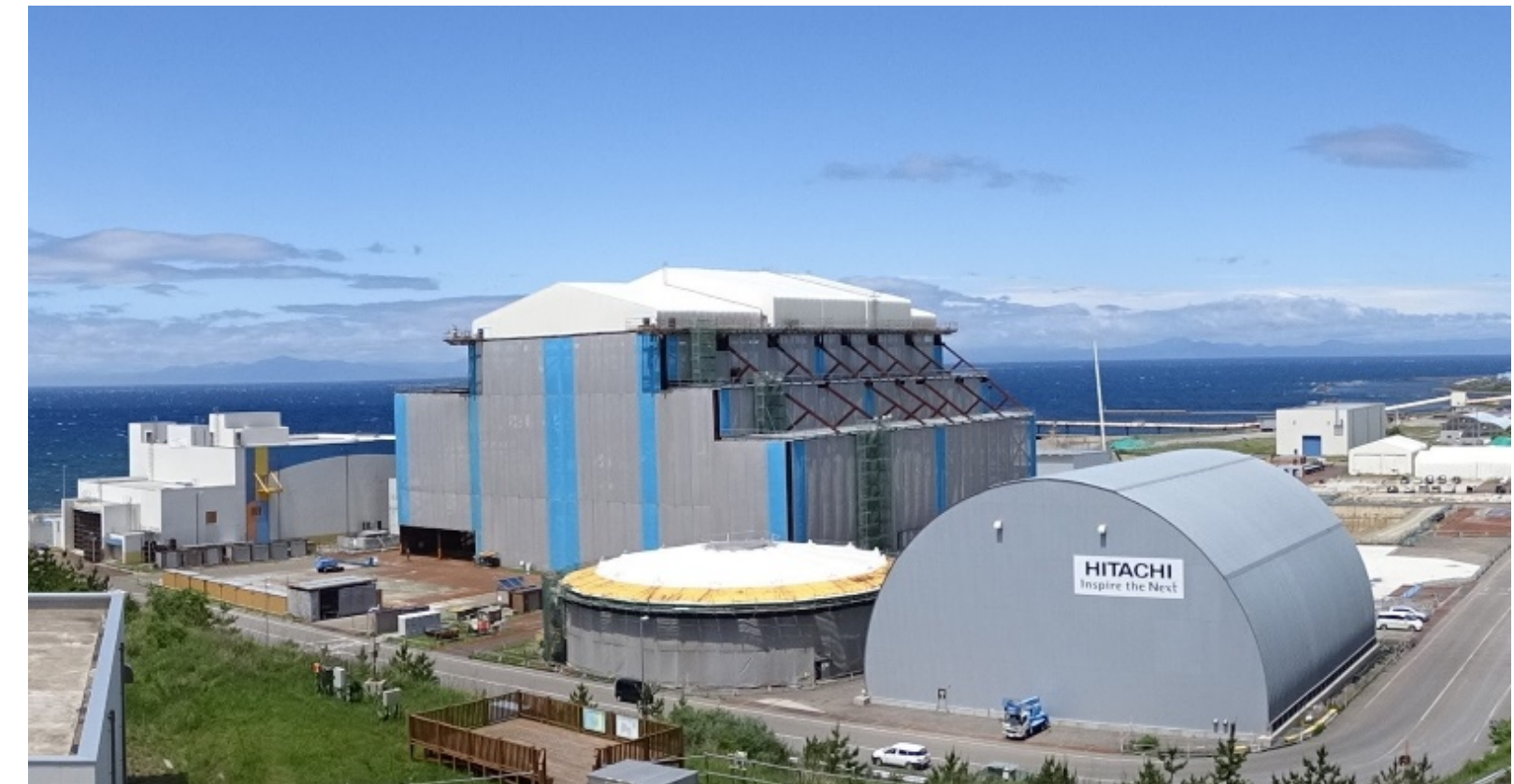
大間原子力発電所建設状況
