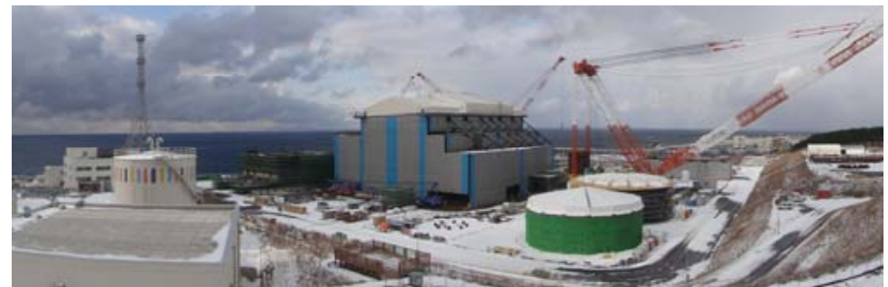
建設状況 (2012年1月現在)
