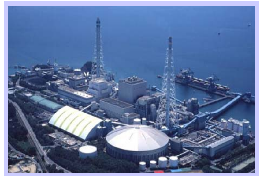
竹原火力発電所
