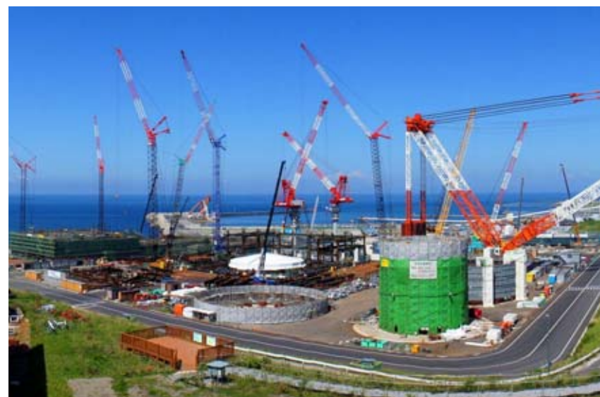
大間原子力発電所建設工事(22年9月撮影)
