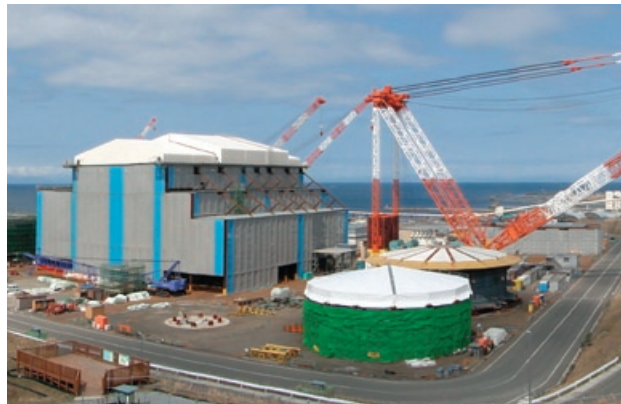
大間原子力発電所建設工事の状況(平成24年4月撮影)
