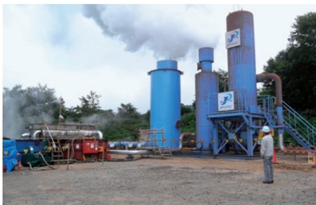
湯沢地熱プロジェクト(噴気試験)
