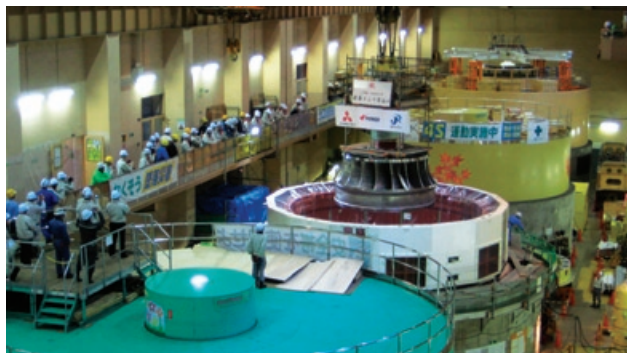
田子倉発電所(福島県南会津郡只見町)
