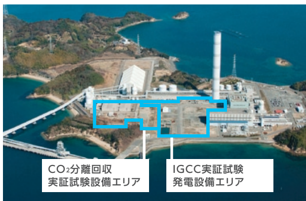
大崎クールジェン実証試験プラント建設地点
