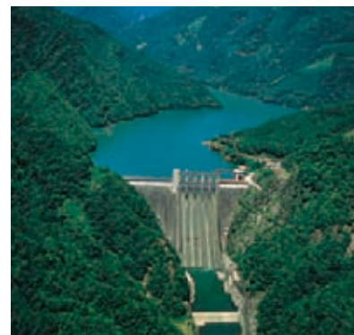
佐久間発電所(静岡県)
