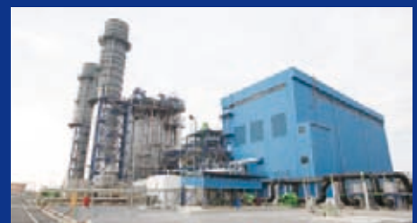
ウタイガス火力発電所(タイ)
