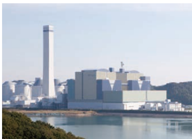
橘湾火力発電所
