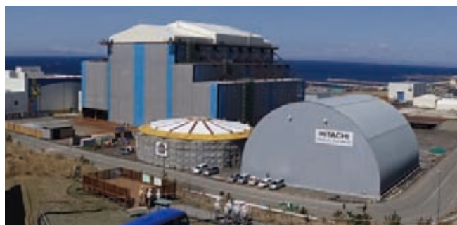
大間原子力発電所の建設状況(2018年6月時点)
