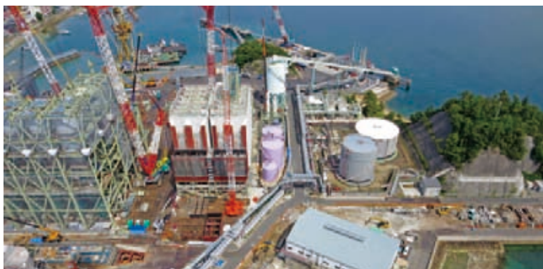
建設工事の様子
