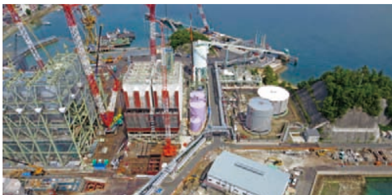
建設工事の様子
