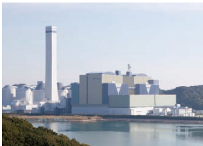
橘湾火力発電所
