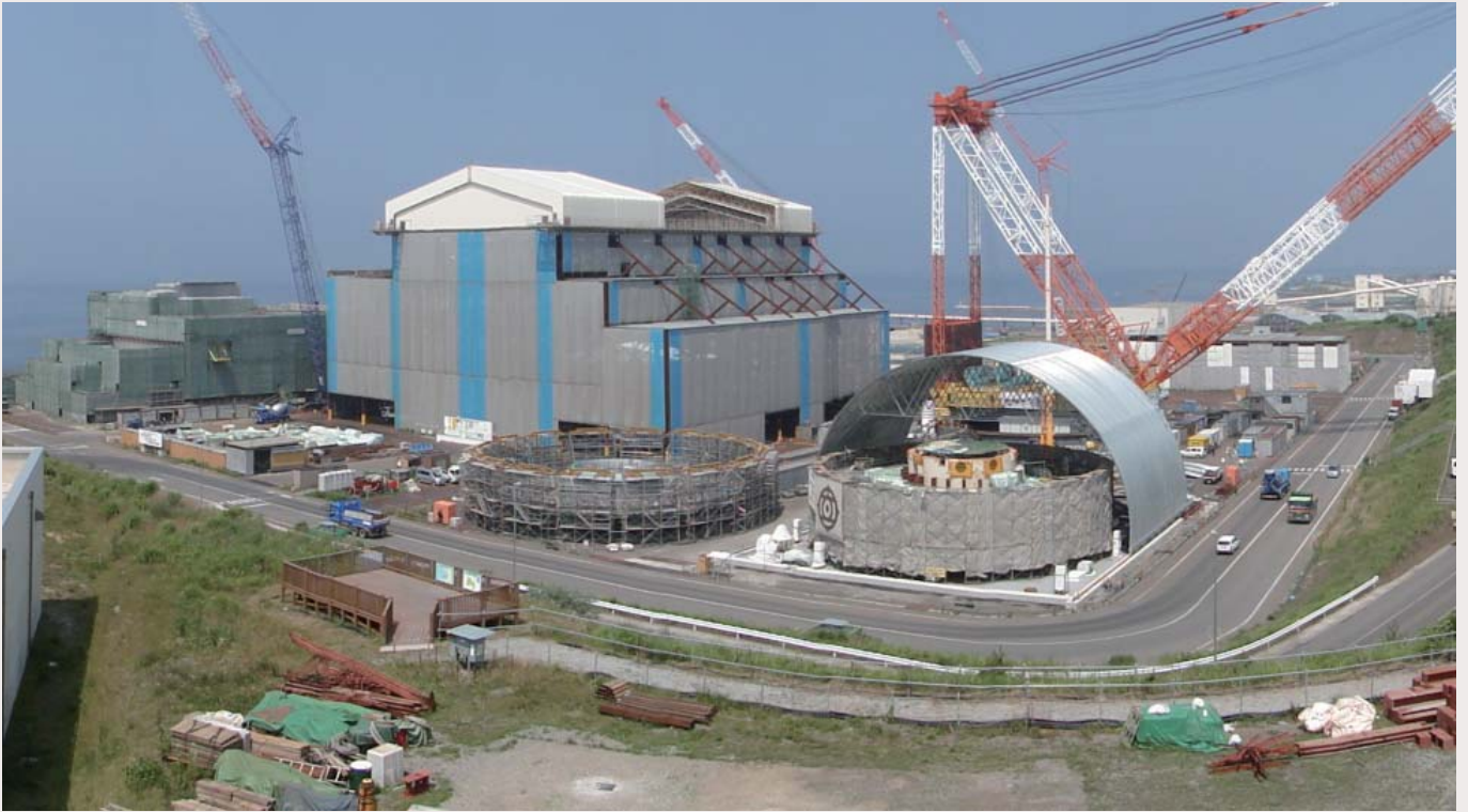
大間原子力発電所の建設状況(2014年7月時点)
