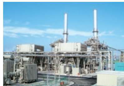
ベイサイドエナジー市原発電所 (千葉県)
