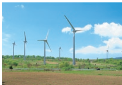
郡山布引高原風力発電所 (福島県)
