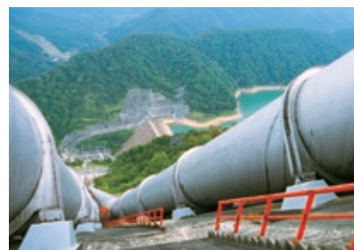
奥清津発電所(新潟県)
