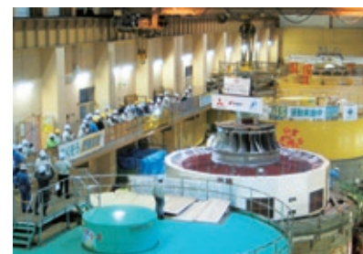
田子倉発電所一括更新工事状況(福島県)
