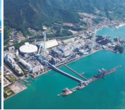
竹原火力発電所(広島県)
