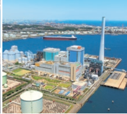
磯子火力発電所(リプレース後)
