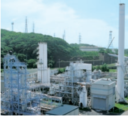
EAGLEパイロット試験設備(福岡県)
