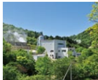
鬼首地熱発電所(宮城県)
