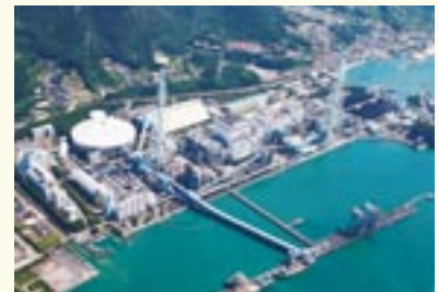
竹原火力発電所（広島県）
