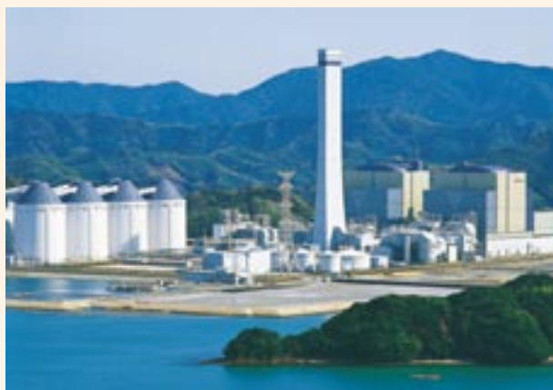
橋湾火力発電所(徳島県)
