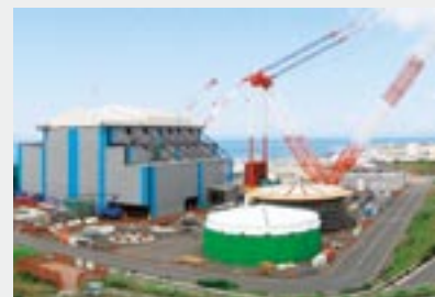
大間原子力発電所の建設状況(2011年8月撮影)
