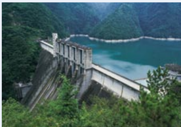
佐久間発電所(静岡県)
