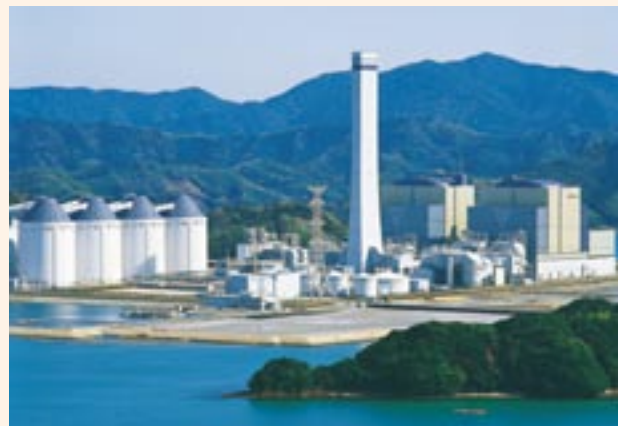
橋湾火力発電所(徳島県)
