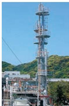
松島火力発電所2号機におけるCO<sub>2</sub>分離回収実証試験設備
