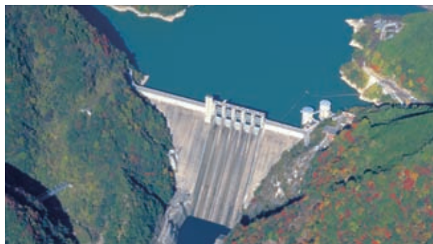
佐久間発電所(出力35万kW、静岡県)
