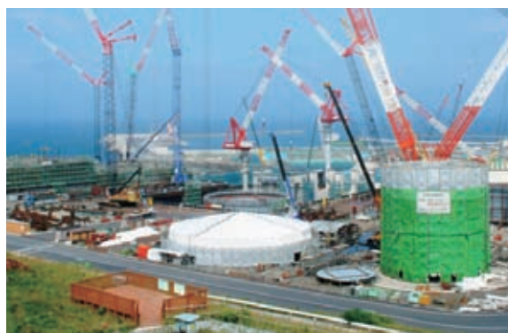
建設工事状況（2010年7月現在）
