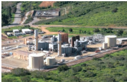
米国オレンジ・グローブ発電所
