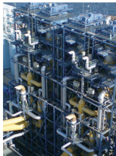
礮子火力発電所新2号機乾式排煙脱硫装置
