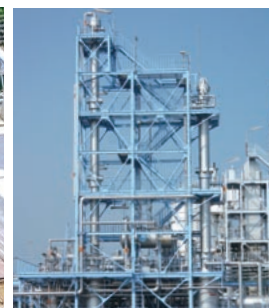
CO 2 分離回収設備
