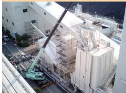
木質バイオマス受入れ設備(松浦火力)
