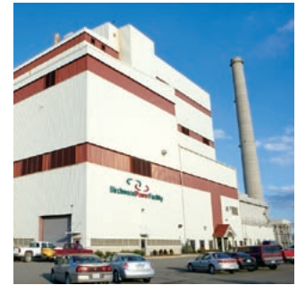
バーチウッド発電所(米国バージニア州)
