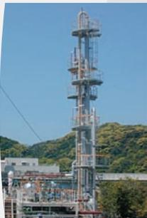
松島火力発電所2号機におけるCO<sub>2</sub>分離回収実証試験装置
