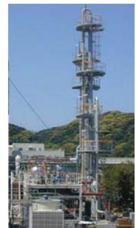
松島火力2号機におけるCO<sub>2</sub>分離回収実証試験装置
