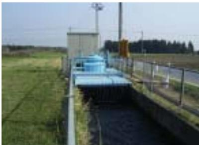
農業用水路の落差を利用する「開水路着工用発電システム（ハイドロアグリ）」を共同開発し、実証試験（2005年3月期）を経て実用化しています。
