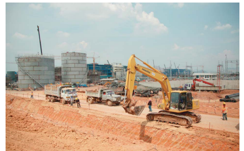
現在建設中のカエンコイ2ガス火力プロジェクト(タイ)
