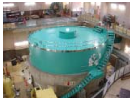
2006年5月に主要設備の一括更新を終え、運転を開始した田子倉発電所4号機
