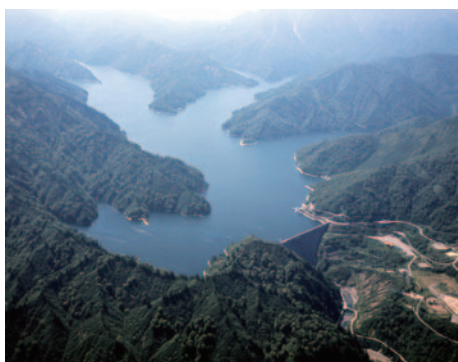
奥只見ダム▶1960年完成。新潟県と福島県の県境にある、阿賀野川水系の重力式コンクリートダム。高さ157m。最大出力は56万kW。
