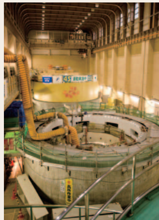
現在工事中の3号機。
