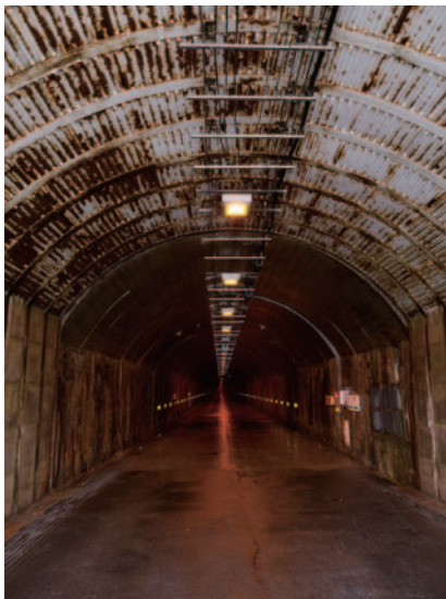
19本のトンネルからなるシルバーライン。
