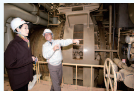
水圧鉄管の巨大さと轟音に驚く筆者。
