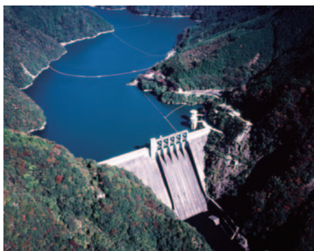
佐久間ダム▶1956年完成。静岡県天竜川にある、高さ155.5mの重力式コンクリートダム。最大出力は35万kW。
