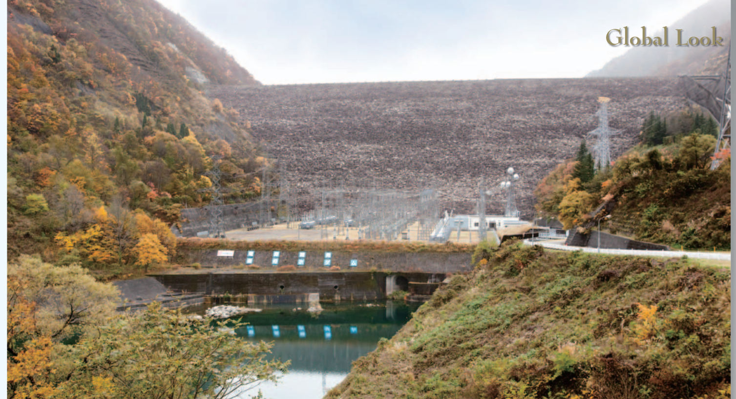
御母衣ダム全景。湖の総貯水容量はロックフィルダムでは日本で2番目に大きい。
