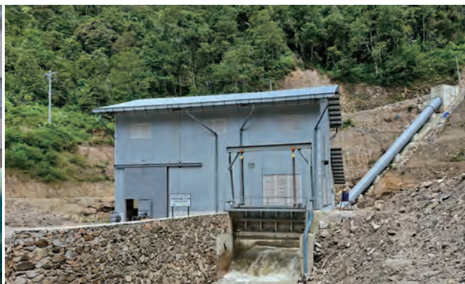
Punga発電所（外観）
