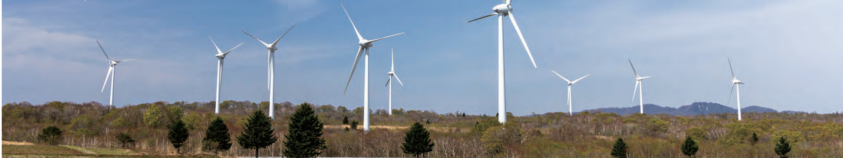
標高約1,000mの布引高原に並ぶ風車。靑空を背景にそびえ立つ風車は全部で33基ある。
