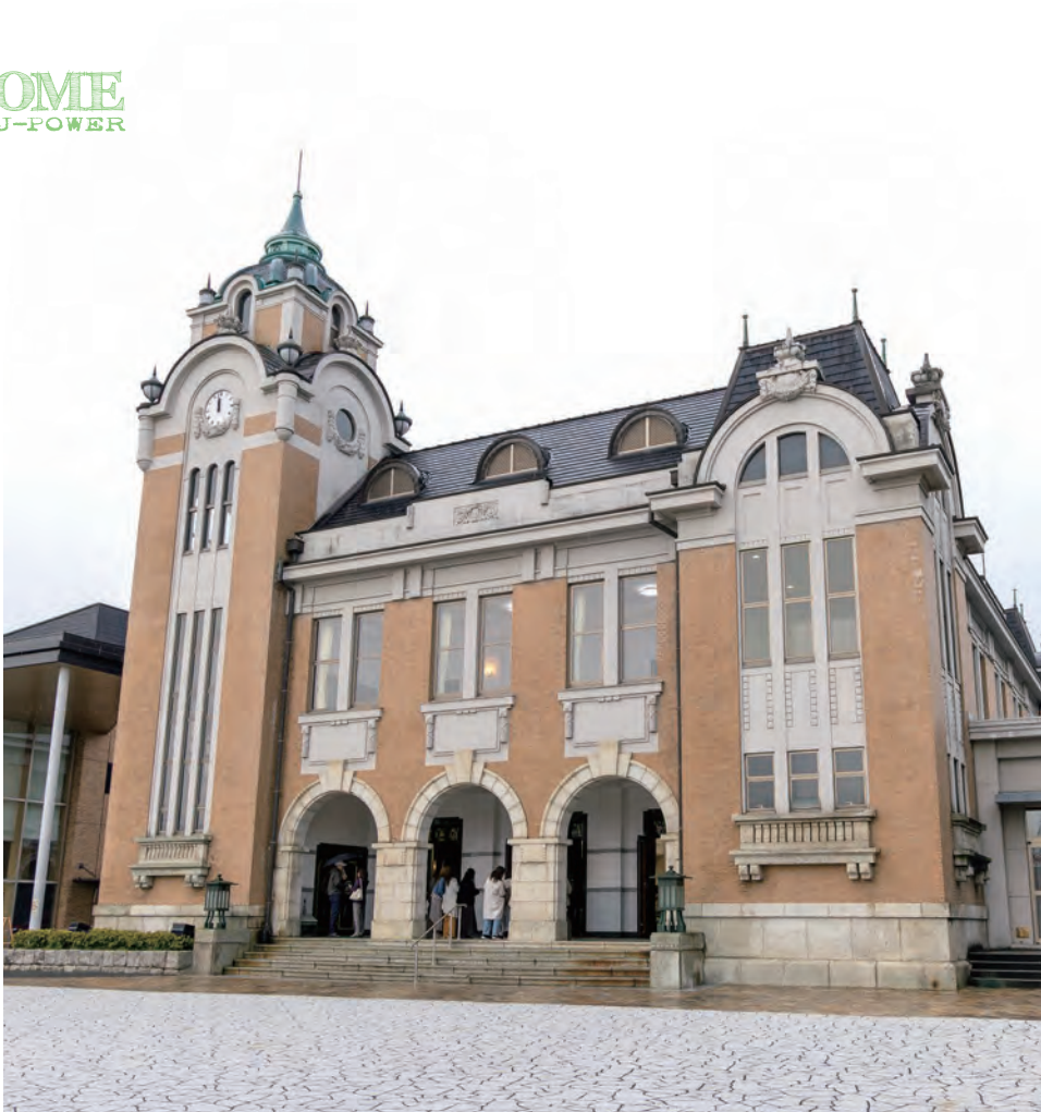
郡山市の市制試行を記念して1924年に建設された郡山公会堂。今も様々なイベントが行われている。
