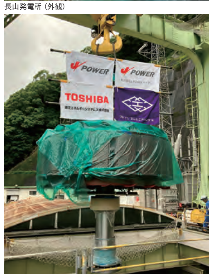
長山発電所1号機リパワリング工事の様子（回転子吊込み）
