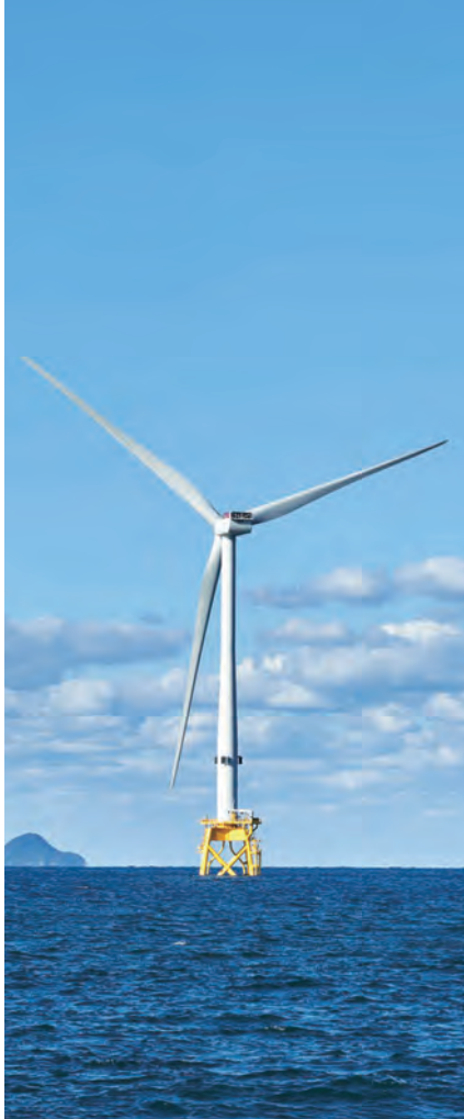
風車の直径は174mで、現時点で国内最大。
