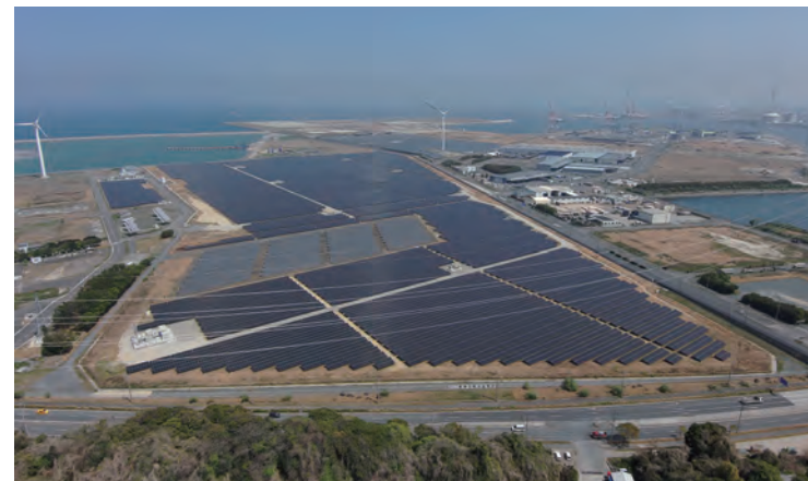
ドローンによる空撮写真
