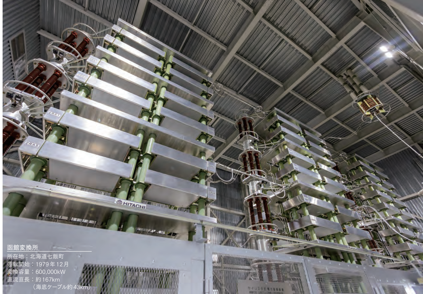
函館変換所のサイリスタバブル。交直変換の心臓部で、直流電流を流すためのスイッチを担っている。
