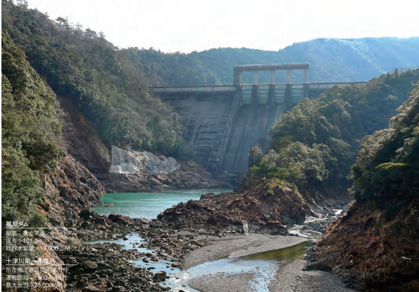
熊野川の下流から見た風屋ダム。重力式コンクリートダムで、1960年に運転を開始した。
