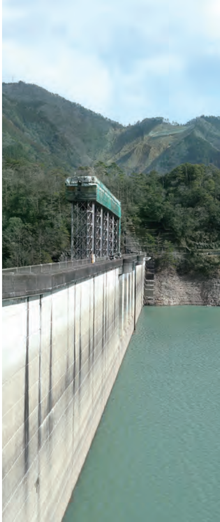
堤高101mの風屋ダムの天端。
