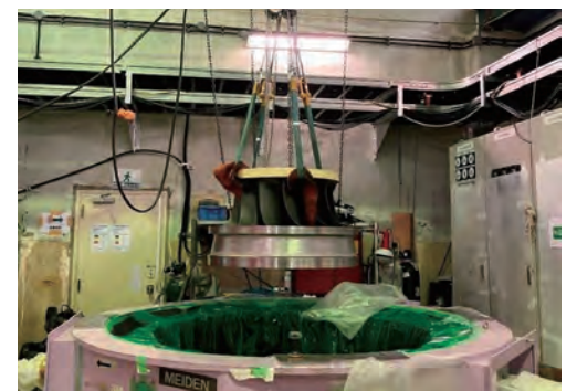
2号機新型水車ランナ吊り込み
