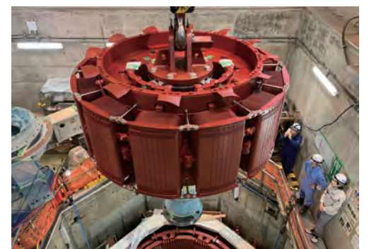
新発電機回転子吊り込み
