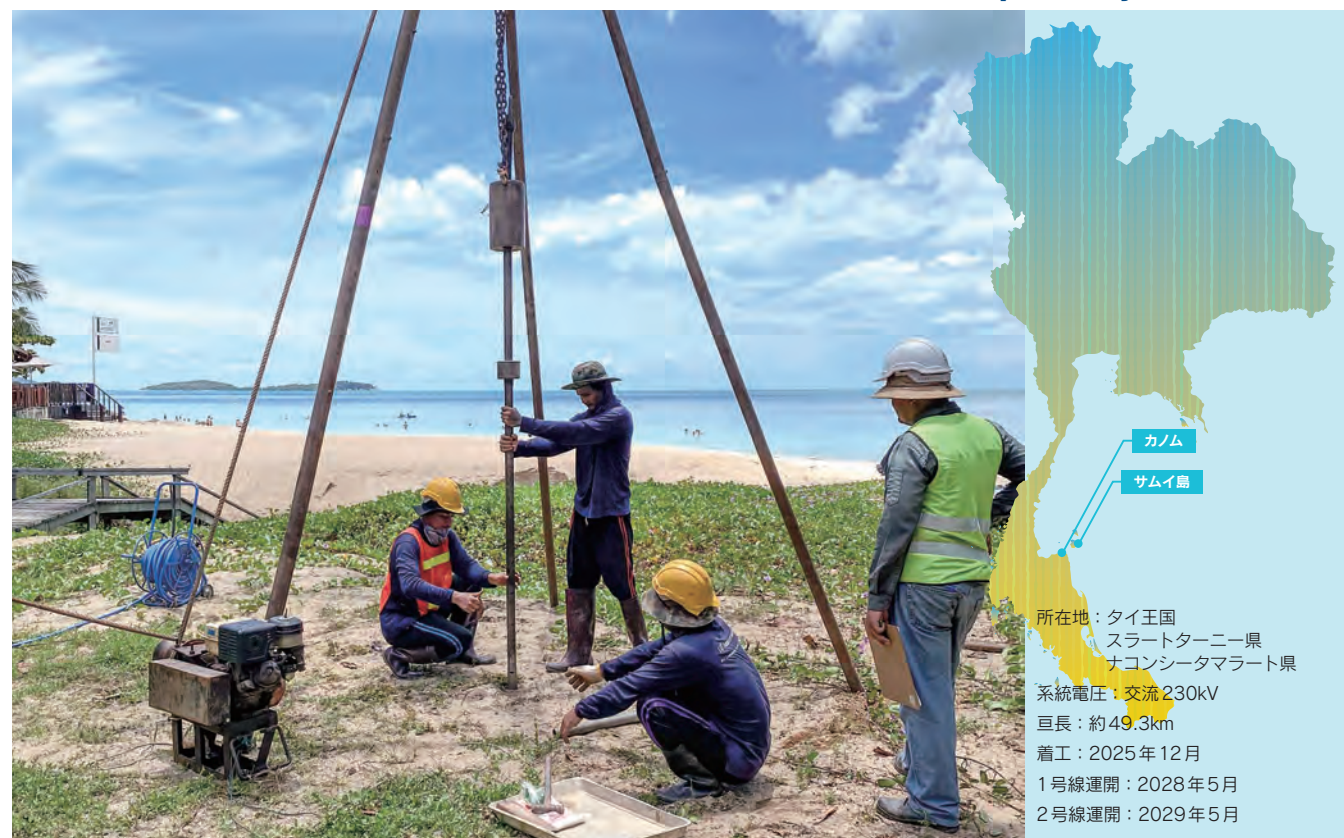
サムイ島海底ケーブル陸揚地点でのボーリング調査。
