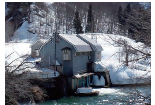
末沢発電所（全景）
