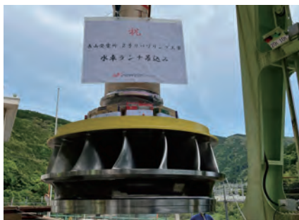
長山発電所2号機リパワリング工事の様子（水車ランナ吊込み）
