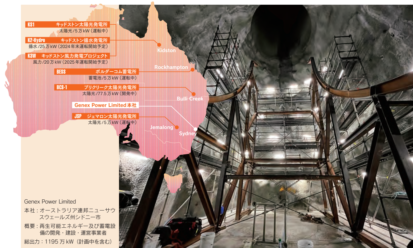
工事中のキッドストン揚水発電所の地下。
