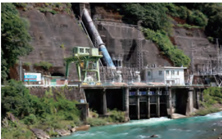
長山発電所（外観）
