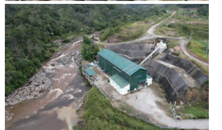
Sion発電所 堰および取水口（上）、Sion発電所 外観（下）
