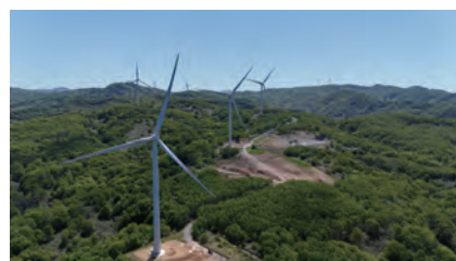
上ノ国第二風力発電所
