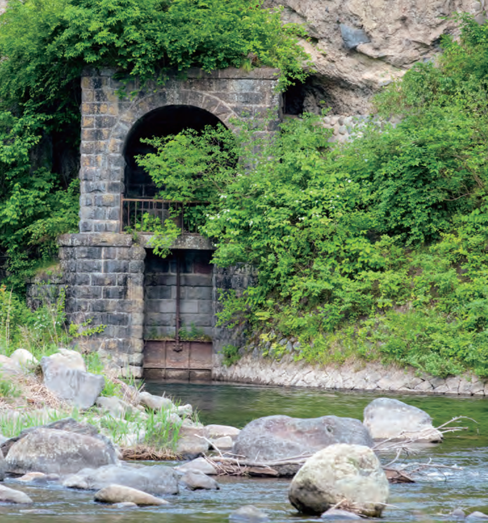
西岩崎の旧取水口。
