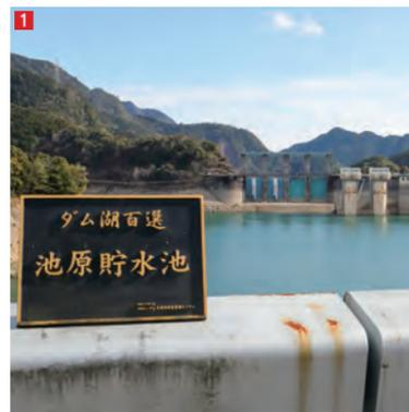
1 ダムの天端（手前側）と洪水吐（奥側）を分離して、ダム放流時の下流域への影響範囲を低減する工夫がなされている。 2 洪水吐の耐震裕度を高めるため、門柱に鉄筋を多数埋め込んでいる。 3 耐震裕度向上の進捗を精密にチェック。同様の工事は運転開始以降で初という。 4 ダム堤体は貯水量や季節変動で「たわみ」が生じるため、0.1mm精度で定期測定する。 5 流域3発電所の業務をカバーするには、土木担当者間の密な連携が欠かせない。
