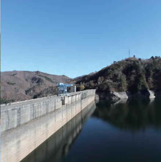
右／ダム下の広場から見上げる田子倉ダム。左／田子倉ダム上流部。田子倉ダムは重力式コンクリートダムで、高さは145m。
