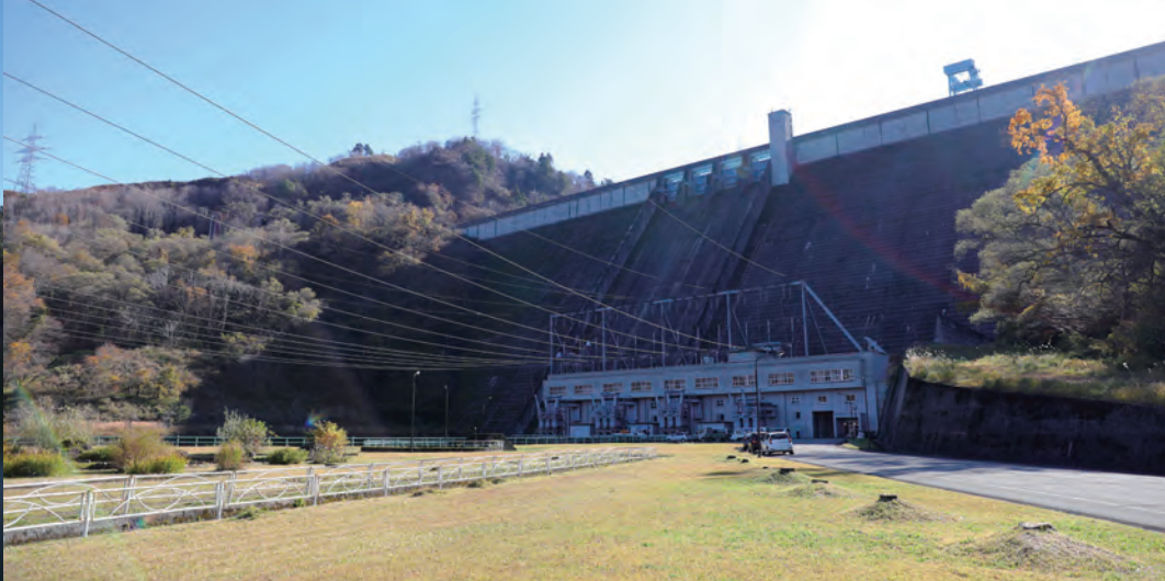
右／ダム下の広場から見上げる田子倉ダム。左／田子倉ダム上流部。田子倉ダムは重力式コンクリートダムで、高さは145m。
