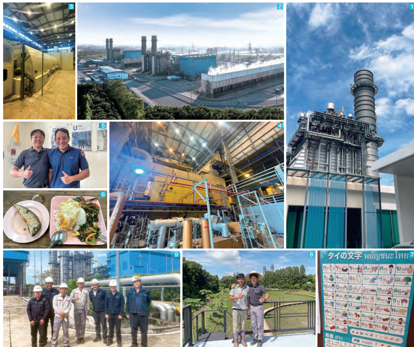
1 青空にそびえる煙突とボイラー。 2 ノンセン発電所の全景。手前の蒸気が出ている設備は冷却塔。 3 蒸気タービン発電装置。 4 ガスタービン発電装置。ガスタービン発電装置から発生する高温排気をボイラーに導いて熱回収を行い、ボイラーで発生した蒸気で蒸気タービンを回し発電する。熱効率に優れた発電方式。 5 発電所長のコウレークさんと富江さん（左）。 6 発電所までの行程で食べたレストランのランチ。 7 デスク横にタイの文字表を貼って、日々タイ語を勉強している。 8 農場で仲のいい若い作業員と。2 人の右奥に発電所の煙突が見える。 9 発電所の主要メンバーと。左から 4 人目が富江さん。
