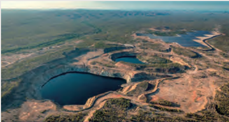
オーストラリア国クイーンズランド州にあるキッドストン揚水発電所（k2-Hydro）の建設予定地。
