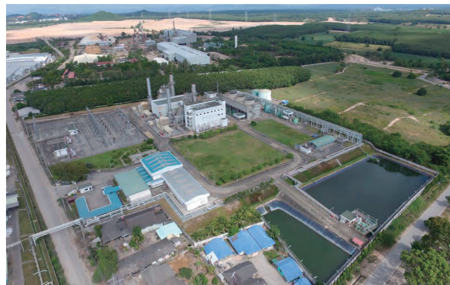
既設発電所写真
