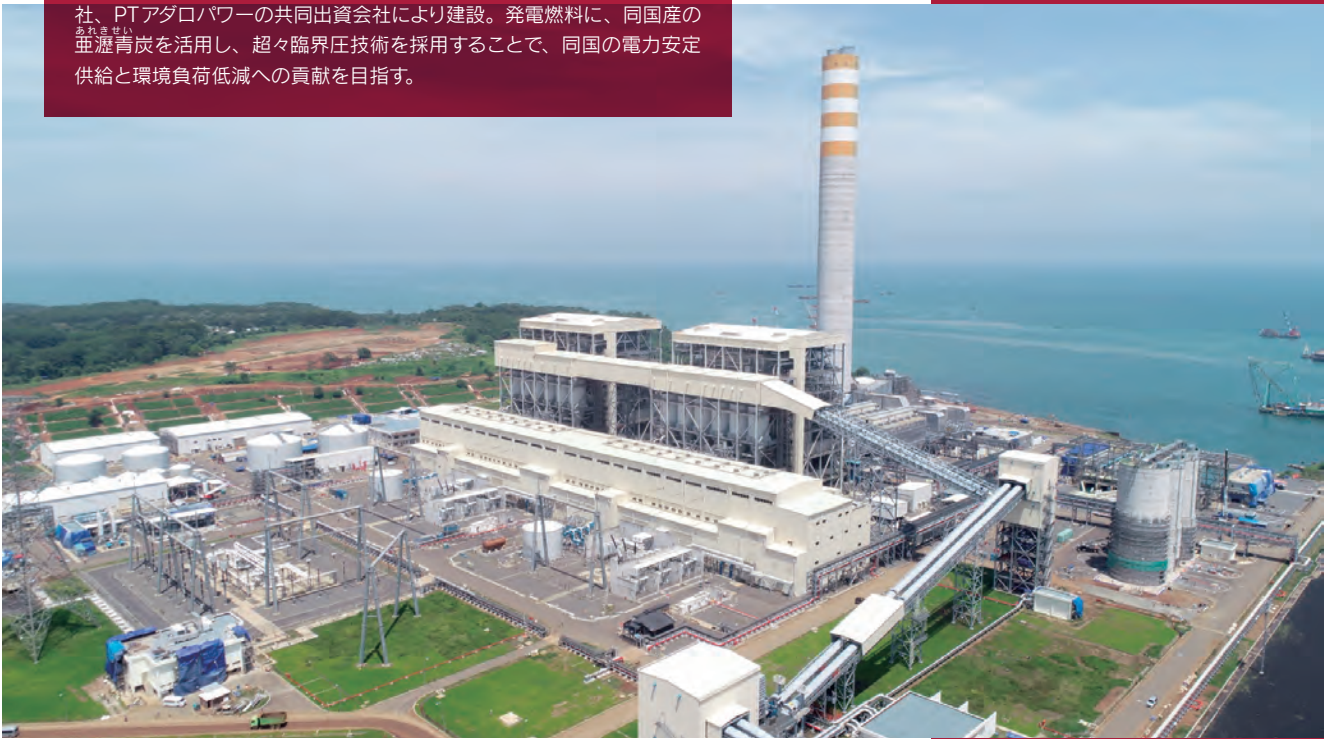
写真提供：PT ビマセナ パワー インドネシア
