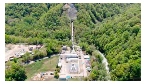
新桂沢発電所全景
