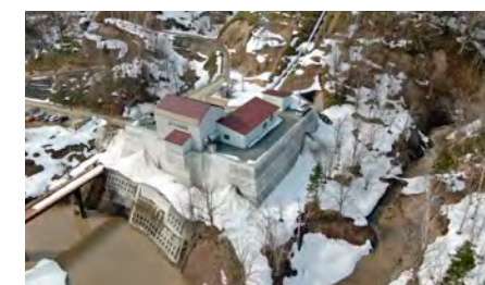
熊追発電所全景
