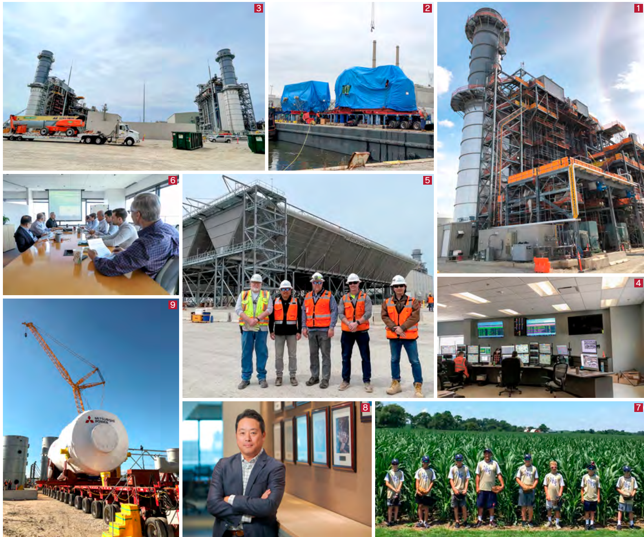
1 煙突の右に見えるのは排熱回収ボイラー。ガスタービンを回した排ガスの熱を使って水蒸気をつくる。 2 建設現場に搬入される蒸気タービン(右)と発電機(左)。 3 2台の発電プラントが並ぶジャクソン火力発電所。 4 整然とモニターが並ぶコントロールルーム。 5 左から2番目が田嶋さん。現地でもともに働いたスタッフと ともに。 6 J-POWER USA 社内でのミーティングの様子。 7 ご子息の野球チームとアイオワ州を訪ねた際の写真。映画『フィールド・オブ・ドリームス』のロケ地 で撮影。 8 米国時代の田嶋さん。J-POWER USA 社内。 9 ガスタービンは日本企業の製品。
