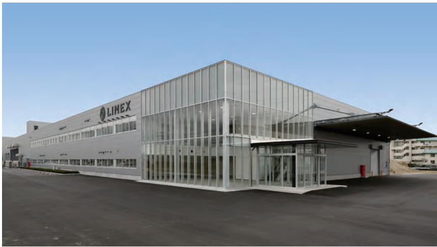
昨年竣工した宮城県多賀城市の国内第2プラント。年間2万5000トンのLIMEX生産能力を持つ。
