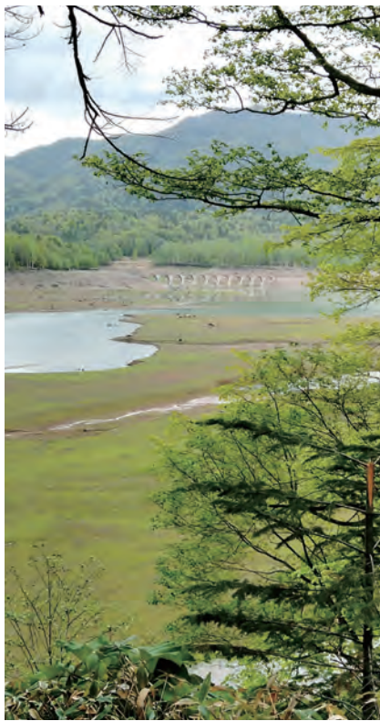
展望台から見たタウシユベツ川橋梁。小さくしか見えない。
