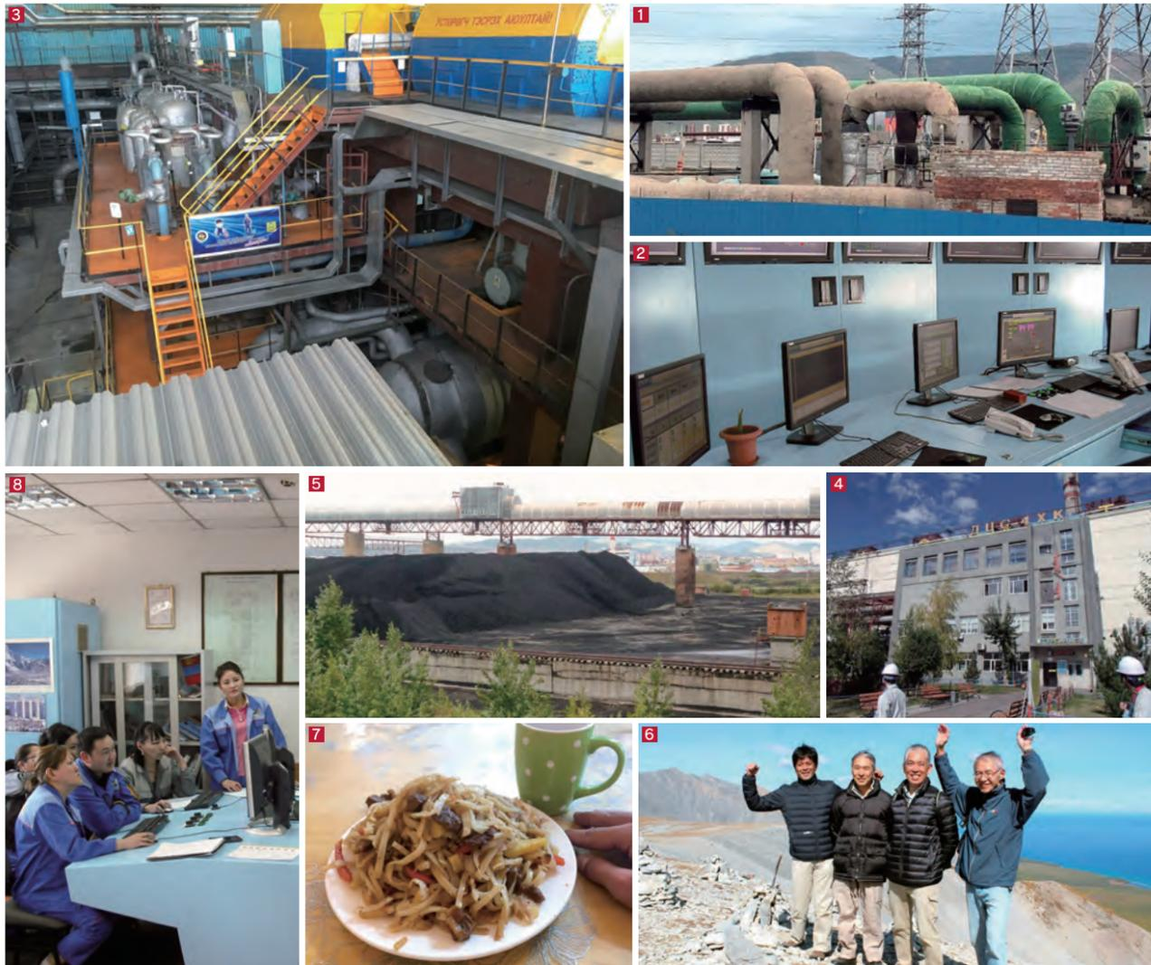
1 温水を市内に供給するパイプと回収するパイプで色が異なる。 2 発電所に最新の制御装置が導入された。 3 各機器、センサーと制御装置を結ぶケーブル工事の施工監理も新垣さんの担当。 4 タービン建屋の外観。 5 ウランバートル第4火力発電所の貯炭場。石炭はすべて国内で産出される。 6 カウンターパートとの小旅行で地方に行った時のJ-POWER スタッフ4名。左端が新垣さん。 7 焼ぎうどんのようなモンゴルの郷土食「ツォイワン」。ヒツジの肉が使われている。 8 発電所で働く人の約4割は女性スタッフ。「日本よりも女性の活躍が進んでいます」と新垣さん。
