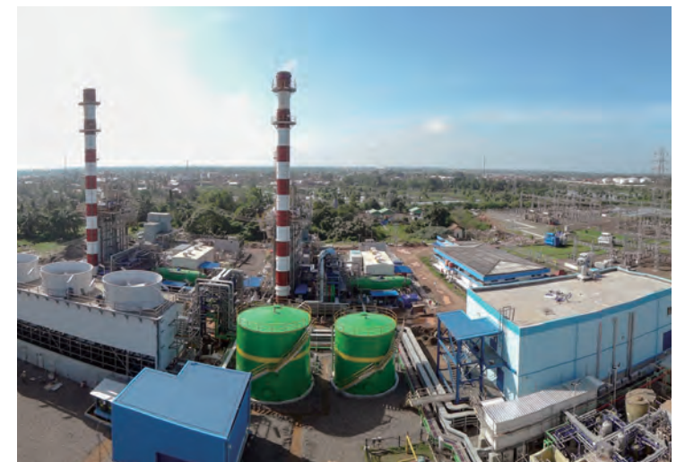
完成したケラマサン火力発電所
