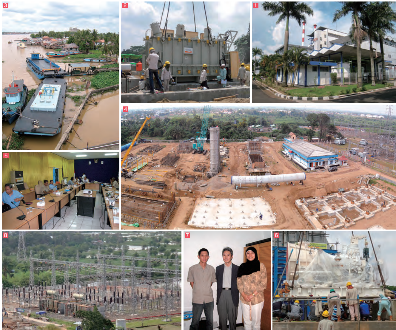
1 工事現場の隣地に立つ古いケラマサン火力発電所の建屋。プロジェクトは、この発電所の増設工事という位置づけ。 2 変圧器の据え付け工事の様子。 3 発電所に冷却水を引き込むための取水口の川周辺。 4 2012年8月頃の土木工事の様子。 5 クライアントであるインドネシア電力会社との打ち合わせ。 6 蒸気タービン据え付け工事。蒸気タービンとガスタービンは日本製。コンバインドサイクル発電は、ガスタービンの運転時に発生する排気ガスを回収し、その熱で蒸気を生成、その蒸気によって蒸気タービンを運転させるもの。 7 現地のスタッフと。中央が目黒さん。スタッフとは主に英語でコミュニケーションを取った。 8 新設された発電設備。
