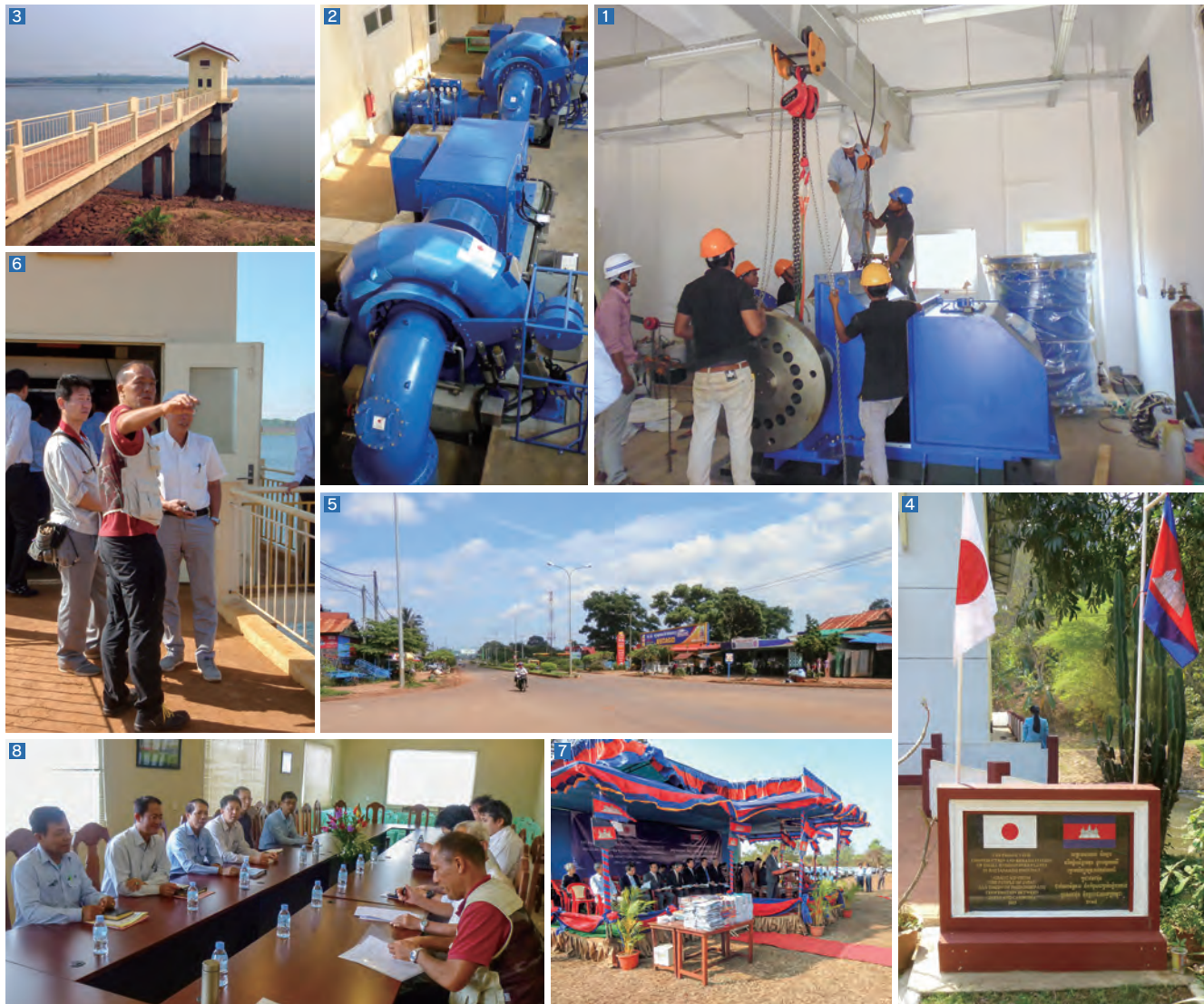
1 オチュム第1発電所での水車据付作業（新設 265kW × 1 台）。 2 オチュム第2 発電所の水車発電機はすべて更新した（設備更新 480kW × 2 台）。 3 オチュム第1 ダムに新設した取水塔。 4 日本の無償援助により建設されたと記されたオチュム第2 発電所の記念碑。 5 バンレン市内の様子。州都といっても空が広い。 6 オチュム第1 ダムの取水塔前で関係者に状況を説明する土屋さん。 7 起工式にはカンボジア政府高官や日本大使館の関係者も参加した。 8 カンボジア電力公社との打ち合わせ風景。写真右前が土屋さん。
