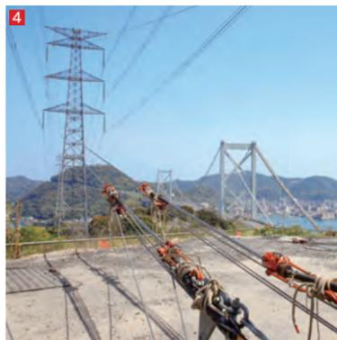
1 只見幹線の住宅密集地における鉄塔建替工事。停電作業で奥側の高い鉄塔（赤白塗装）を建てた後、手前の既設鉄塔（灰色塗装）を解体する。 2 送電線沿いや直下の土地利用が進む市街地では、様々な制約の中で工事用地を確保し、設計・工法等の工夫が求められる（只見幹線）。 3 高所作業に伴う墜落事故から身を守る送電用フルハーネス型安全帯を導入。 4 本州と九州をつなぐ関門連系線の電線張替工事（本州側より）。右手は関門橋。 5 十勝幹線での鉄塔高上工事。
