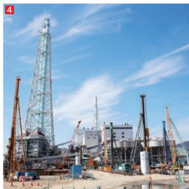
1 同じ建築職のメンバーと、工程の進捗状況を綿密にチェックする。 2 工事の進み具合を現場で確認し、緊張感を保つことも重要な任務だ。 3 新1号機完成後のイメージ。運転開始は2020年6月の予定。 4 新1号機本館の基礎杭の施工の様子。奥には既設の1号機本館が見える。 5 新しい屋内貯炭場の建設現場の状況を確認。変化を肌で感じられるのが仕事の醍醐味だ。
