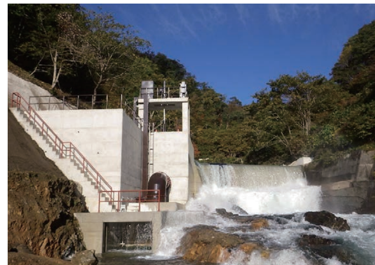
写真左手にある茶色の水圧鉄管から水車発電機に水が送られている
