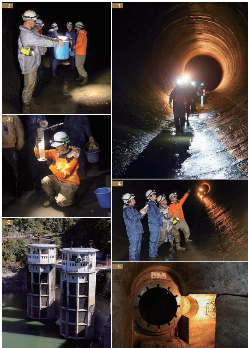
1 ヘッドライトを頼りに真っ暗な導水路を 一步一步踏みしめながら進む。 2 漏水 は、バケツで1分間貯水。 3 バケツに貯 めた水はメスシリンダーへ移し、計量する。 4 壁面の洗掘やはだ落ちも指差し確認。 5 1号導水路に入るためのマンホール。 6 佐久間ダム取水口。この右手の地下に 導水路がある。 7 ダム直下から見上げた 佐久間ダム。
