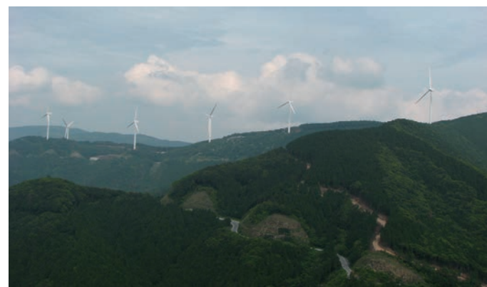
南愛媛風力発電所
