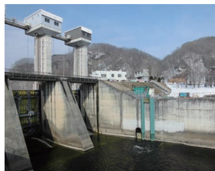
発電所外観写真
