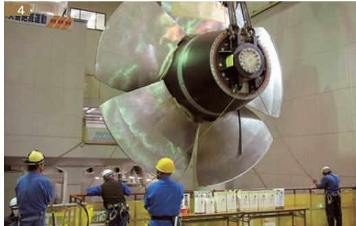
1 水車ランナの据え付けを待つ発電機本体。黒い軸の後方に回転子が収まっている。2 発電機を制御する油圧装置の細密点検も並行して行われていた。3 ステンレス鋼製のブレード（羽根）は1枚あたり7.8トン。この羽根の角度を自動制御しながら、最も発電効率のよい角度を得る仕組みだ。4 点検・整備を済ませた水車ランナを大型クレーンで吊り込む。5 ブレードをランナボスに据え付けている様子。6 バルブ水車発電機の模型。円筒形の水車発電機は、まるで潜水艦のようだ。
