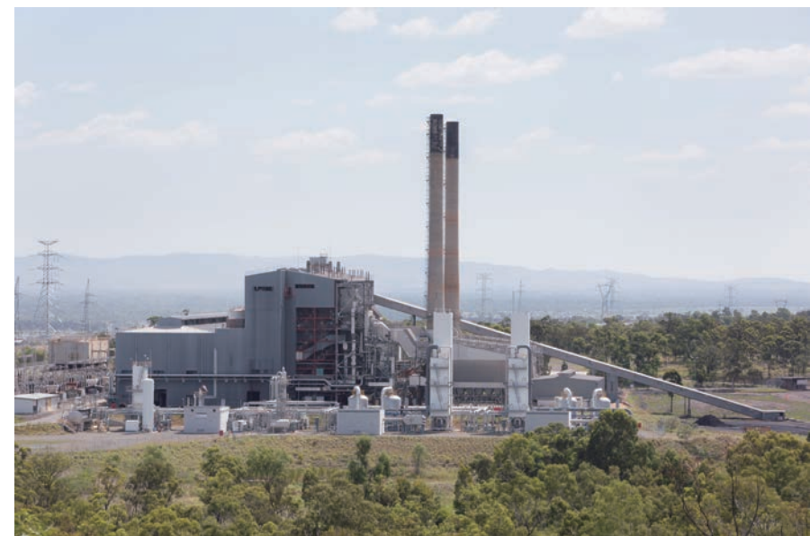
カライドA発電所全景
