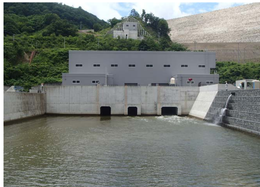
胆沢第一発電所全景
