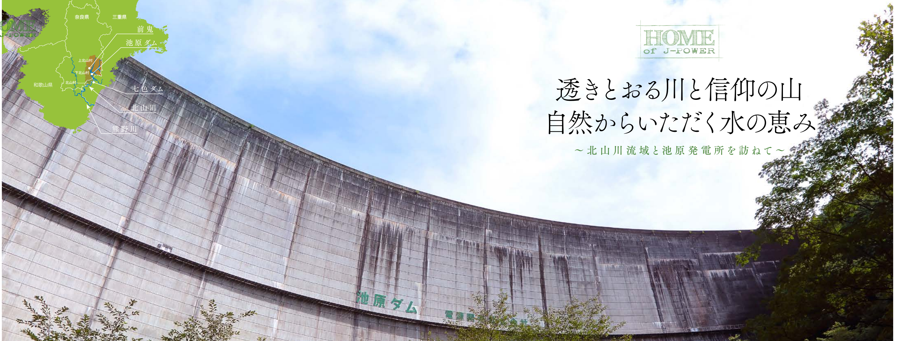
円弧形のコンクリート壁で水を支えるアーチ式の池原ダム
