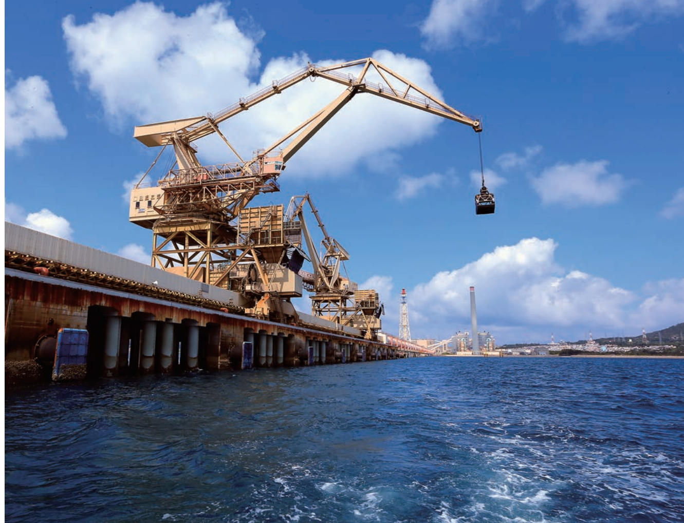
揚炭棧橋に設置されたアンローダー（揚炭機）
