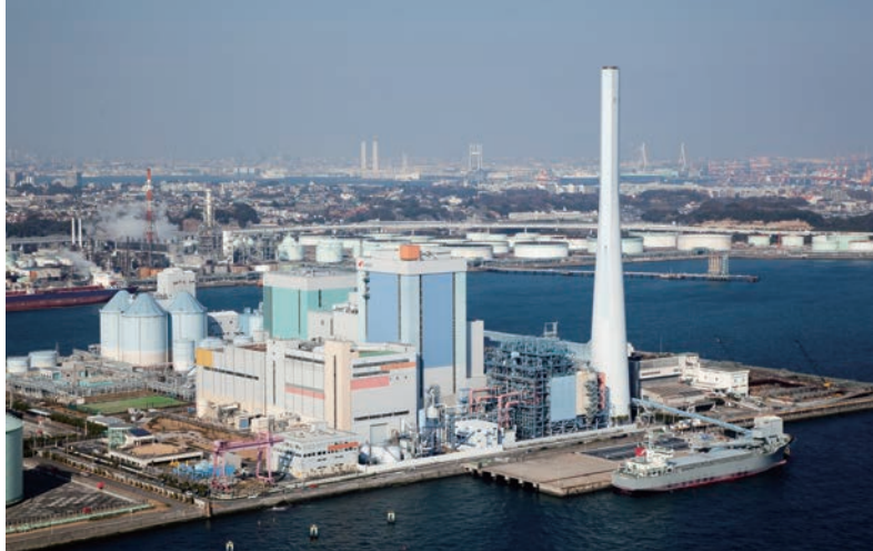
石炭火力で世界最高水準の発電効率を持つ磯子火力発電所（神奈川県横浜市）。
