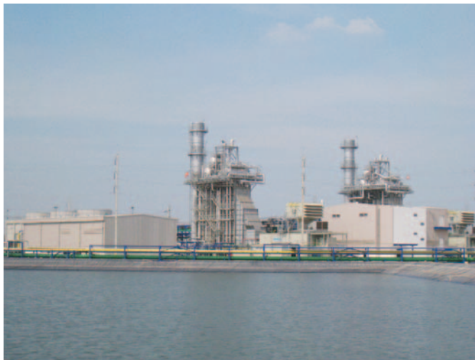
NNKコジェネレーション発電所
