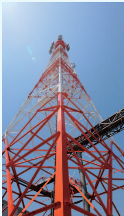
各発電所に信号を送るマイクロ波無線鉄塔。
