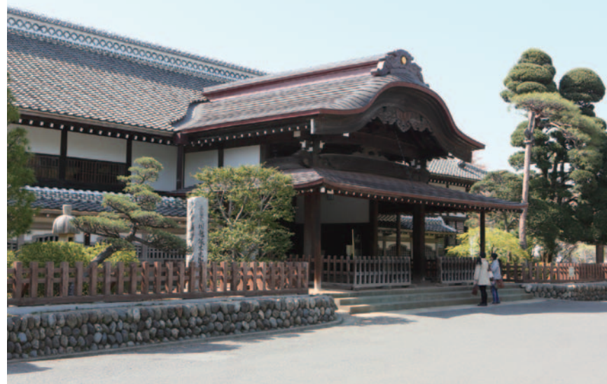
川越城本丸御殿は、1848年(嘉永元年)に、時の城主・松平齊典(なりつね)によって建てられたものの一部。
